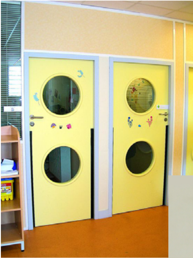
Porte acoustique avec châssis fixe
